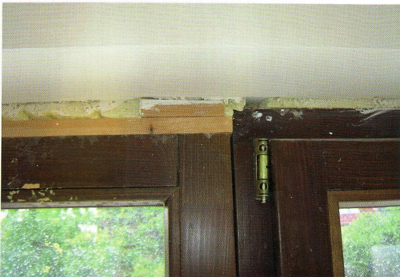
2. kép Az üveg magassági sík eltérésének korrekciós javítása, üvegcsere eredménye a helyszínen, felületkezelő lazúrok színeltéréseivel
