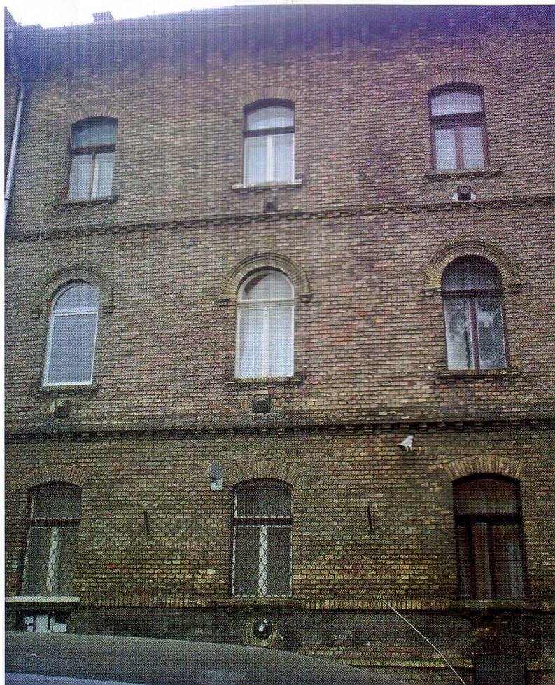
1. kép Színek, nyitásmódok, osztásmódok eltérése megtört a homlokzat képét
