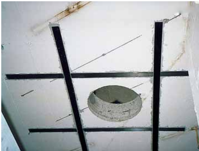
JAVÍTÁS SZÉNSZÁLAS SZERKEZETERŐSÍTŐ CSÍKKAL
