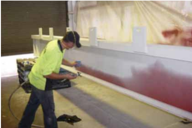
NEDVES RÉTEGVASTAGSÁG ÜZEMI MÉRÉSE – SZÁRADÁS UTÁN ISMÉTELT MÉRÉS ELEKTRONIKUS ESZKÖZZEL
