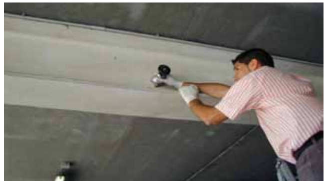
A MEGFELELŐ TAPADÁS ELLENŐRZÉSE
