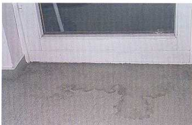
2. kép: Pára megfolyás, beázás miatt átázott, fojtosodó szőnyegpadló
