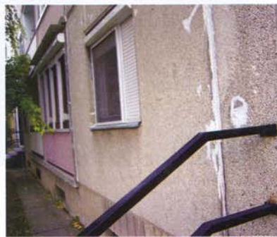
Javított falrepedés
