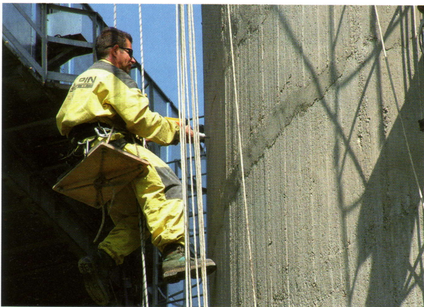
Vasbeton kéménytest vizsgálata. Független, hogy az ÉMI feladatköre mivel bővül még
